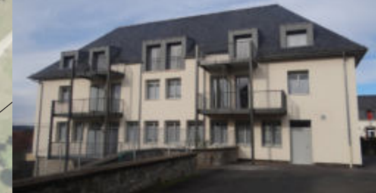
Petit collectif avant et après rénovation (source en haut : Googlemaps)
