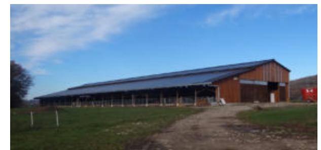
Constructions récentes : pavillon à Gioux en haut, bâtiment agricole isolé entre Gioux et Teldes ci dessus
