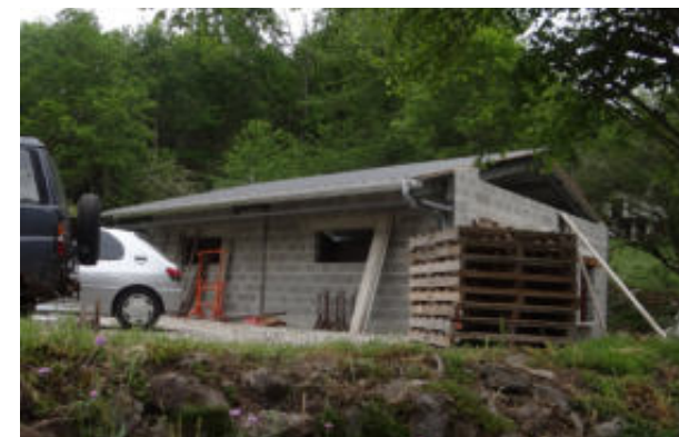
Maison individuelle en cours de construction à Sauronnet
