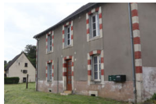
Maisons de ville de l'entrée nord du centre-bourg
