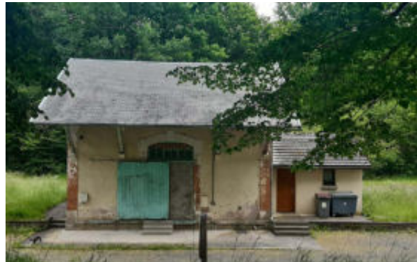
Bâtiment annexe de la gare - Commune de Ydes
