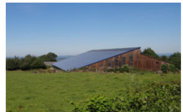
Bâtiment agricole récent et panneaux solaires, la Sisterade
