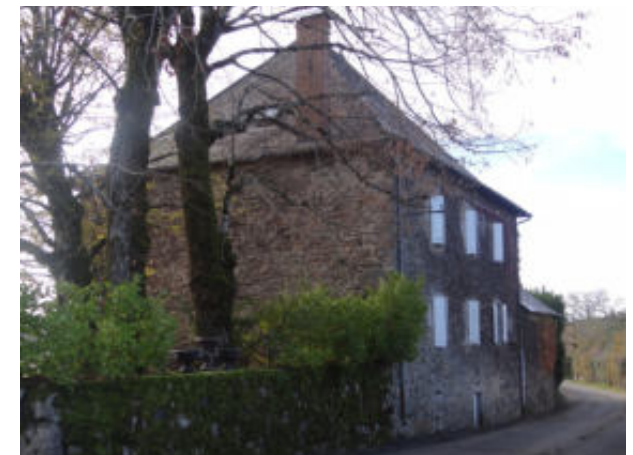
Maison-bloc en hauteur
