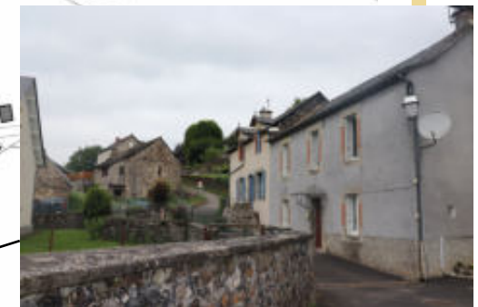
Murets et bâtiments accolés
