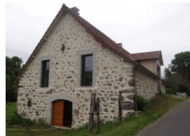
Grange réhabilitée à Druhls
