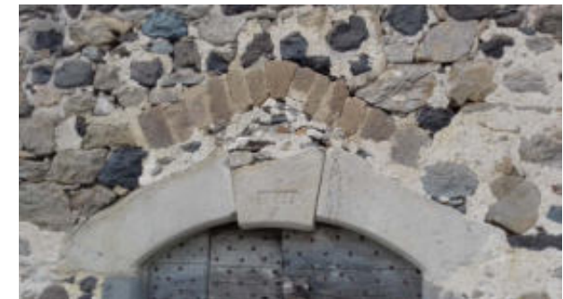
Linteau et arc de décharge - Commune de Saignes
