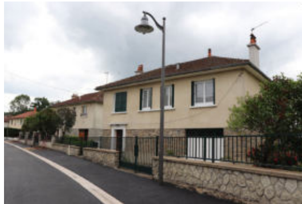
Architecture et implantation typique des lotissements 1960-1980
