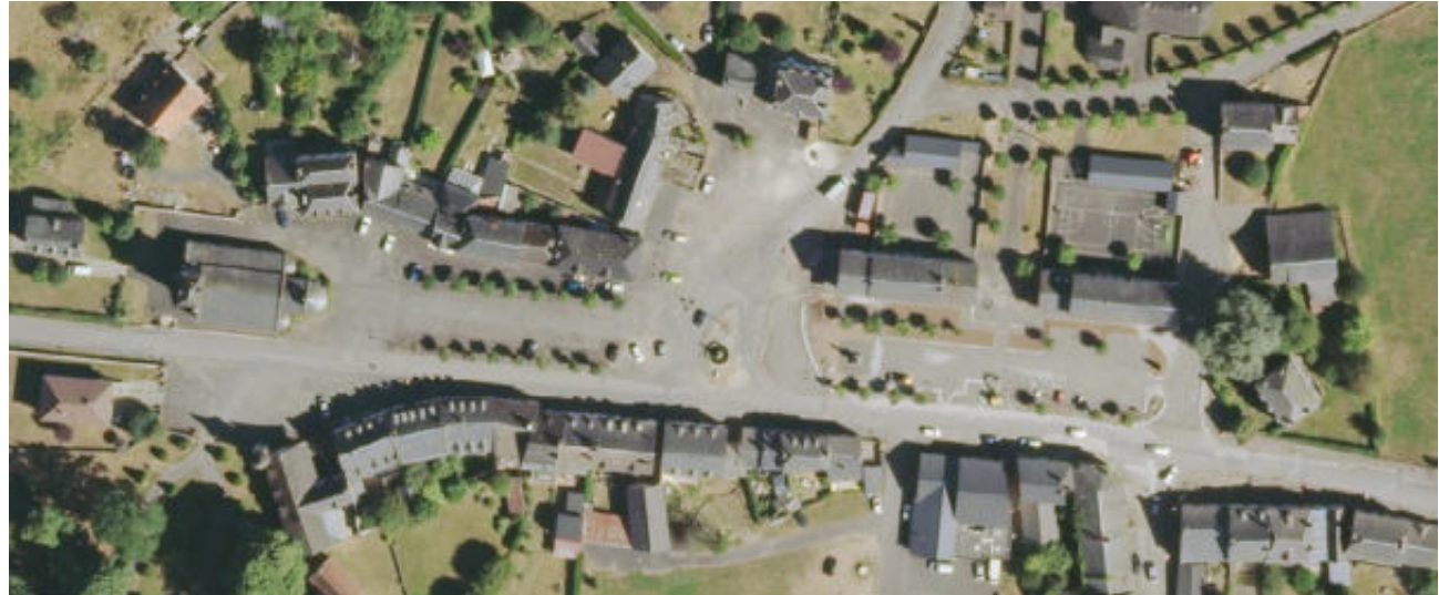
Place centrale du bourg de Champagnac (Source : Orthophoto 2016, IGN)
