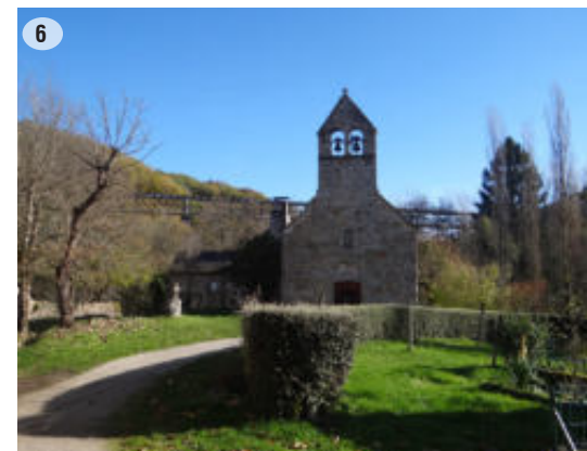
Le front bâti de Champagnac depuis la route de Saint Pierre (photo 4) ; vue sur Gioux et l'étang de Saint Pierre depuis la même route (photo 5) ; Vendes et son patrimoine : l'église que surplombe le viaduc (photo 6)
