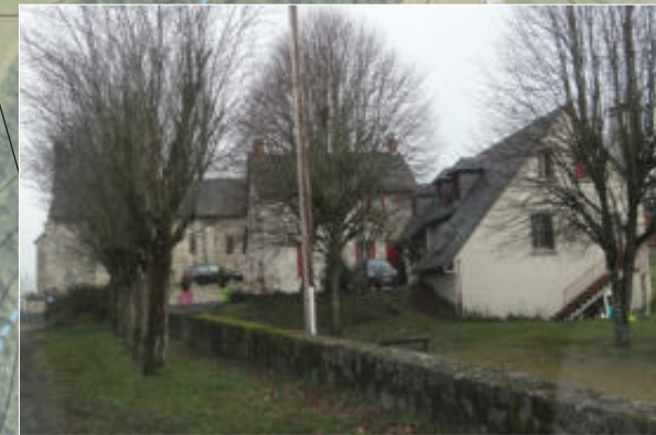
L'église et le bâti ancien accolé
