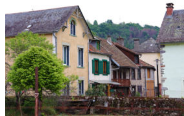
Diversité des tonalités des enduits dans le centre ancien
