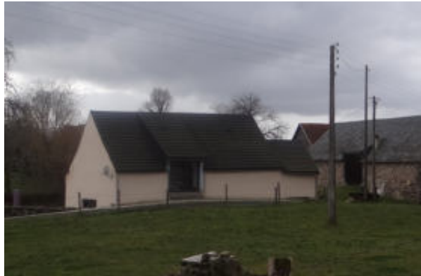
Réutilisation du bâti agricole traditionnel à Chassagne
