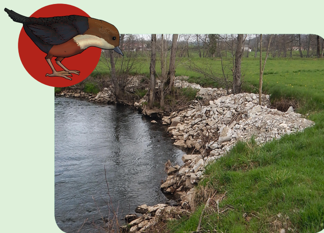
Encoche d'érosion : type de remblais à proscrire
