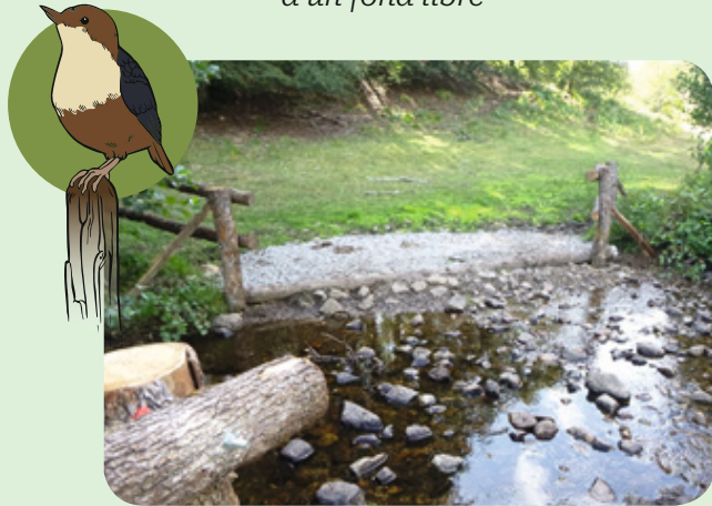
Passage à gué empierré
