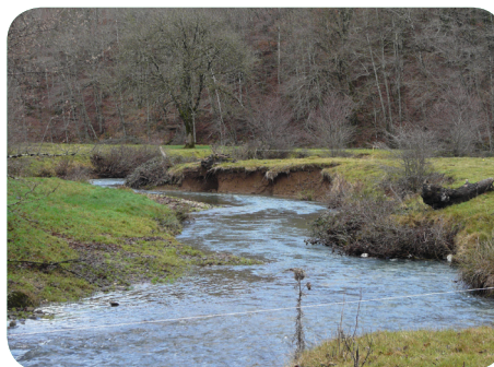
Encoches d'érosion dans des prairies
