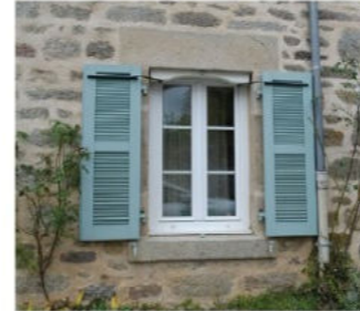
Volets battants électriques (Peyrat le Château, 87)
