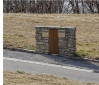
Intégration des coffres techniques dans une opération d'aménagement d'ensemble (La Ségalassière)
