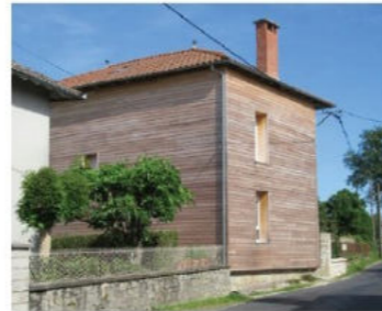
Isolation par l'extérieur des façades nord et ouest : procédé le plus efficace pour réduire les pertes énergétiques, maintien du cachet historique de la façade sud (les coffres de volets roulant devraient être masqués depuis l'extérieur) - Siran
