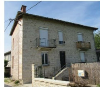
Isolation par l'extérieur des façades nord et ouest : procédé le plus efficace pour réduire les pertes énergétiques, maintien du cachet historique de la façade sud (les coffres de volets roulant devraient être masqués depuis l'extérieur) - Siran
