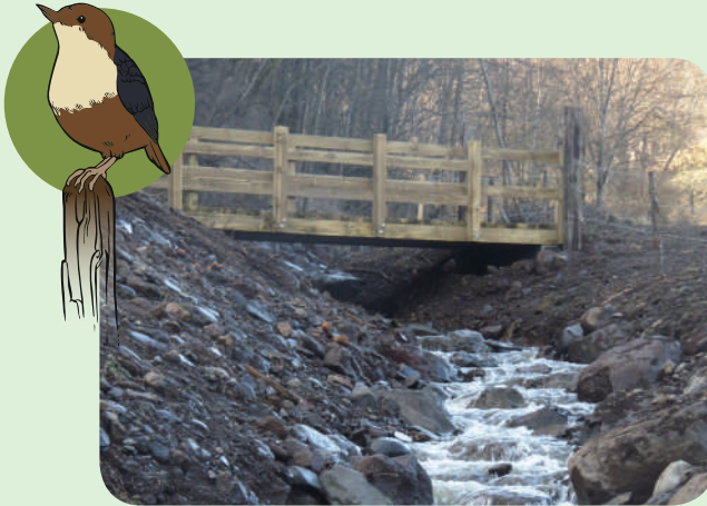
Pose d'une passerelle agricole avec maintien d'un fond libre
