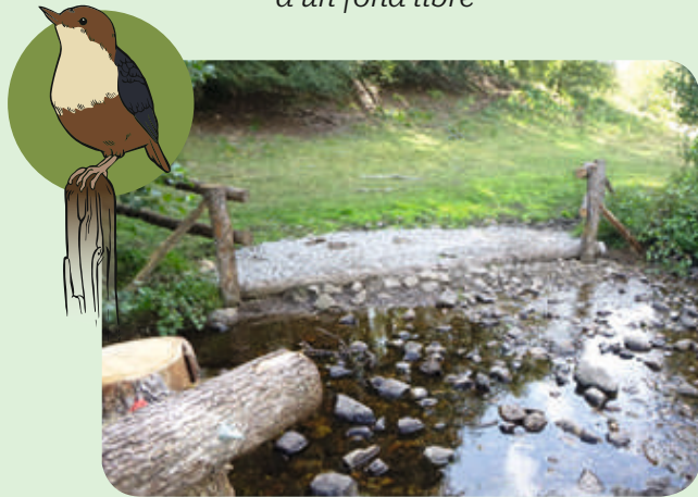
Passage à gué empierré
