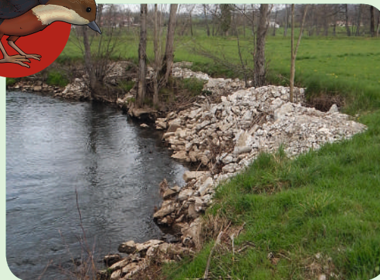
Encoche d'érosion : type de remblais à proscrire
