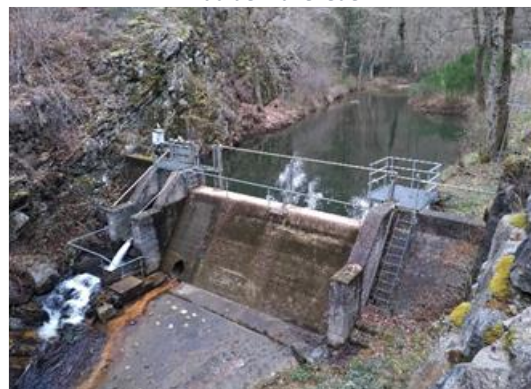
Figure 46 : Photographie du barrage de Lavergne sur le Rau de Piallevedel
