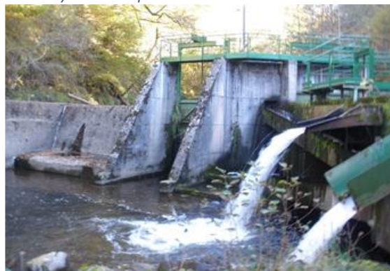
Figure 47 : Photographie de la prise d'eau de la microcentrale hydroélectrique du Bois du Cher sur le Mars
